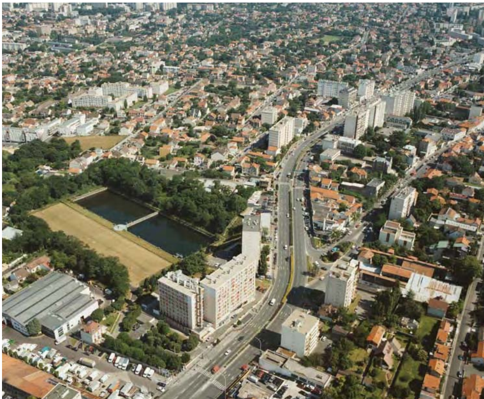
Entrée de ville Nord
