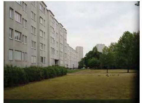
Espaces extérieurs - quartier Mermoz
