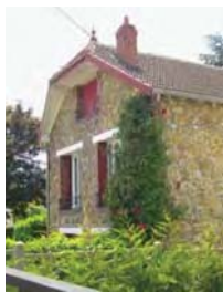
Pavillon en meulière avec RdC réhaussé
