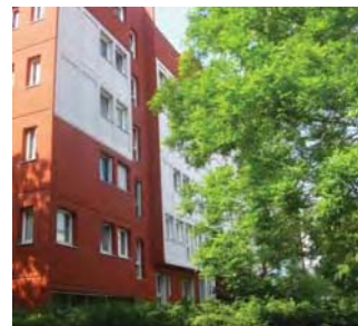
immeuble collectif implanté en second rang, en centre-ville, années 80
