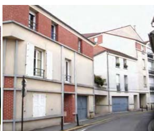
Habitat individuel dense, continu et à l'alignement de la rue
