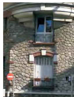
Maçonneries mixtes de briques et éléments de ciment.
