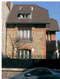
Maçonneries mixtes de briques et éléments de ciment.
