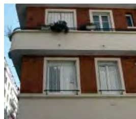
Maçonneries mixtes de briques et éléments de ciment.
