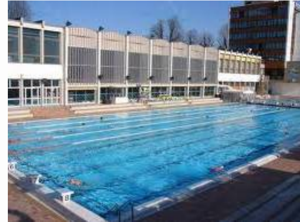
Piscine de Nogent-sur-Marne
