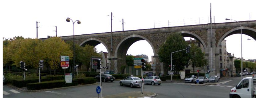
Limite Est : la voie ferrée en viaduc
