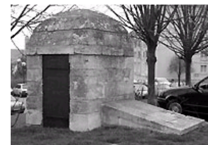
Regards de l'aqueduc
