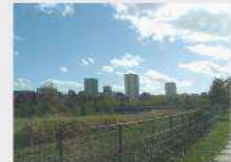
Bassin de rétention
