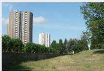
Future coulée verte
