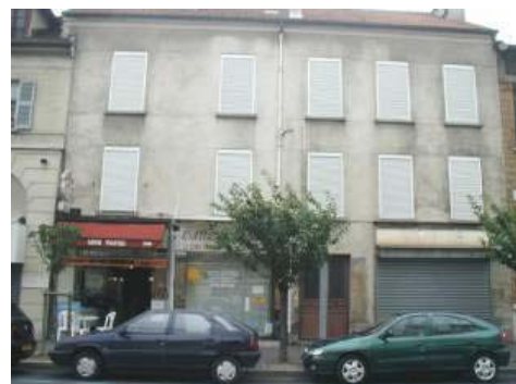
Immeuble partiellement occupé (péril)
