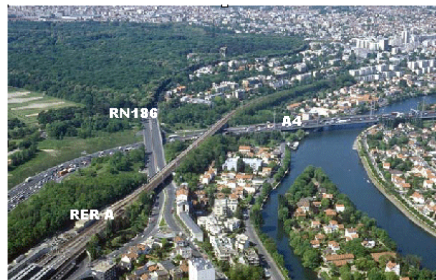
Vue du viaduc A4/A86 (Source : Etat)
