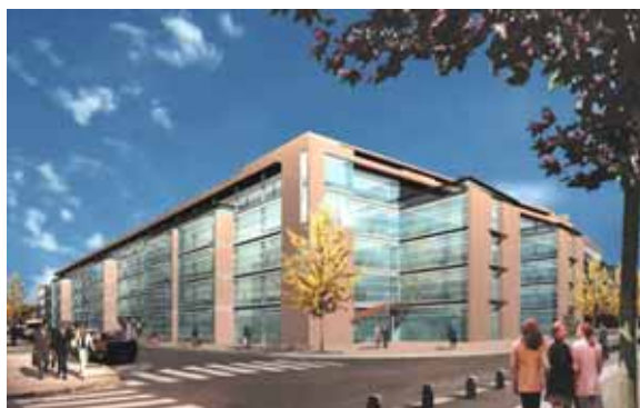
Exemple : Projet rue Truillot en cours de réalisation qui accueillera La Poste
