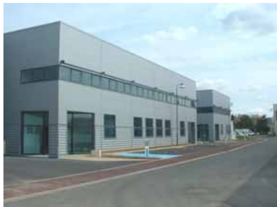
Zone d'activité Mure en cours de réalisation
