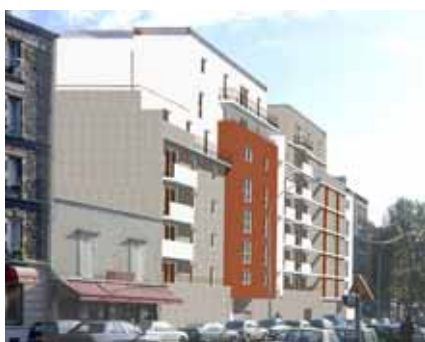
Opération Postillon - 80 logements
