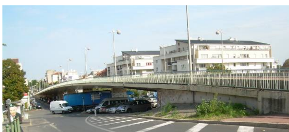
Autopont de l'avenue Victor Hugo
