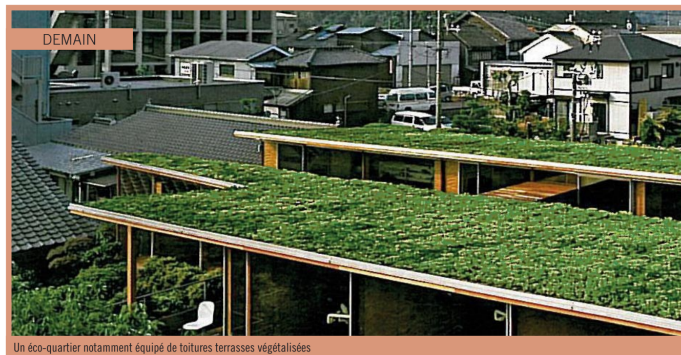
Un éco-quartier notamment équipé de toitures terrasses végétalisées
