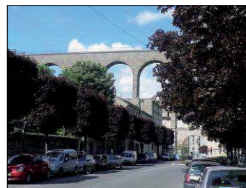
Aqueduc de la Vanne
