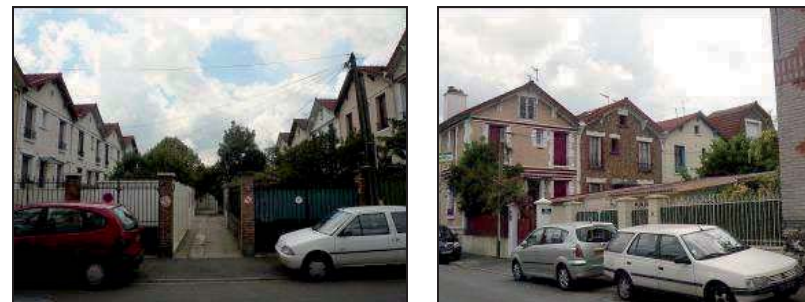
Vues de la rue de la Grange-Ory
