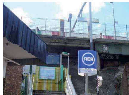
Station de RER Arcueil-Cachan
