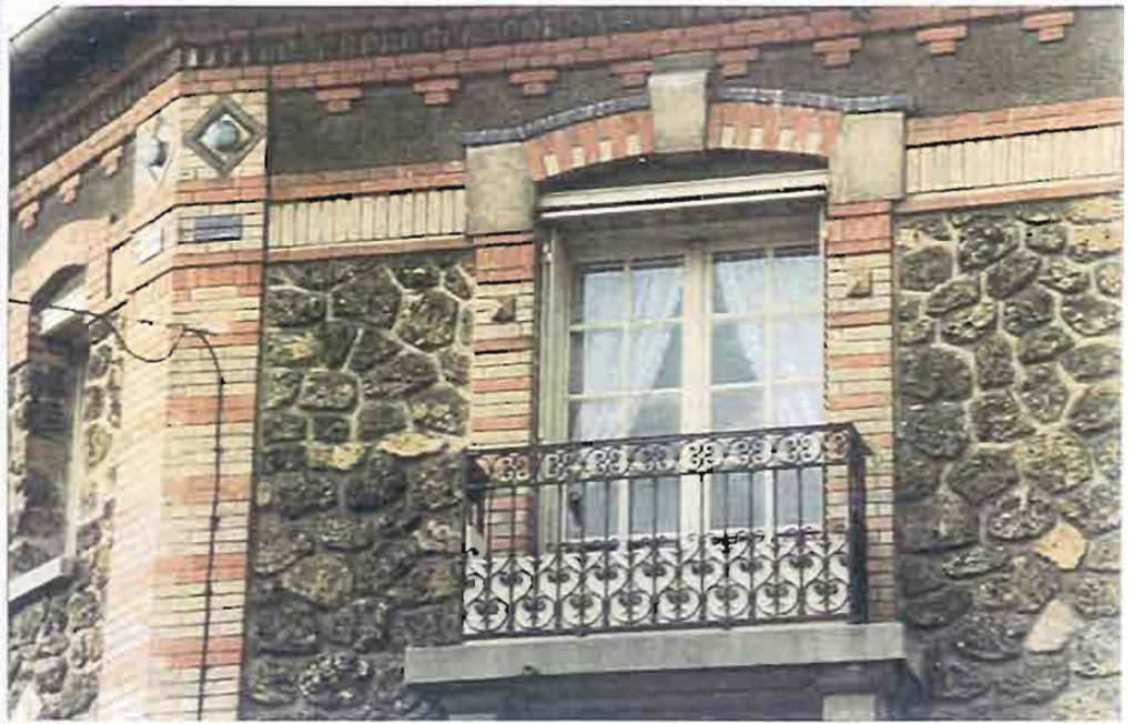
ELEMENTS REMARQUABLES MOULURES PLATRE LINTEAU, ENCADREMENT DE BAIE DIVERSITE DES MATERIAUX, BRIQUE, CERAMIQUE, FONTE, MEULIERE
